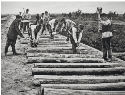
Рис. 2. Процесс укладки шпал
